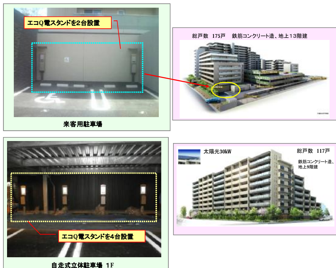
図表 9 普通充電設備（スタンド型）導入事例（新築マンション）
