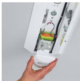
非常用光源(LED)部分のカバーを外します。
